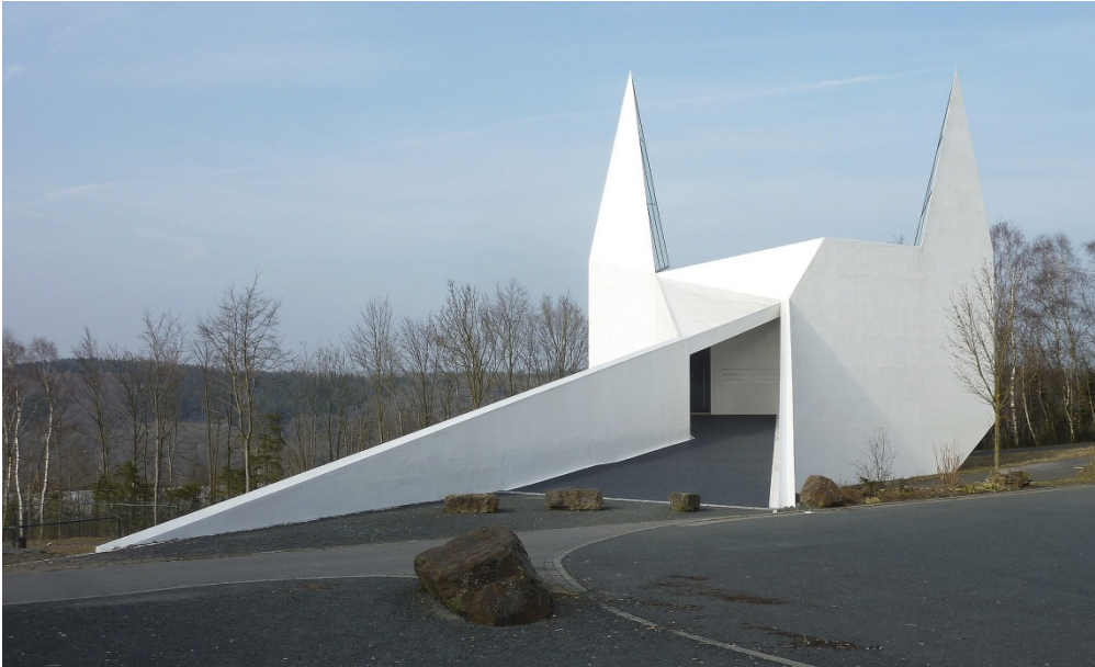
Foto: Von Frank Behnsen, CC BY-SA 3.0, https://commons.wikimedia.org/w/index.php?curid=39660353 Außenansicht der Autobahnkirche Siegerland mit Eingangsbereich
